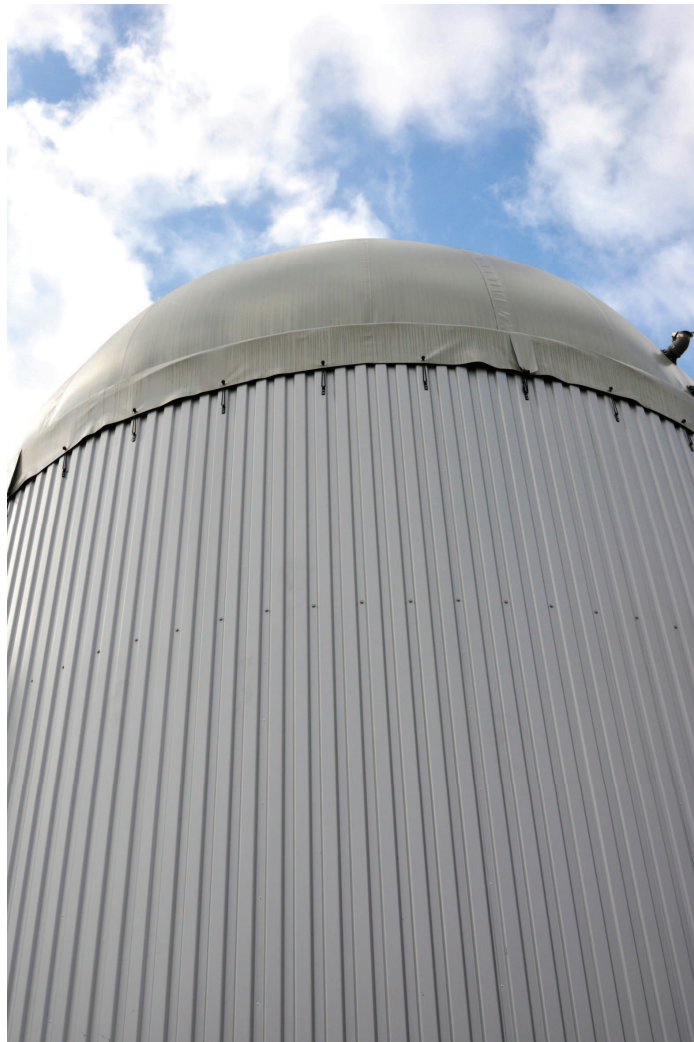
Faulturm der Kläranlage Waldenbuch in Aidlingen
