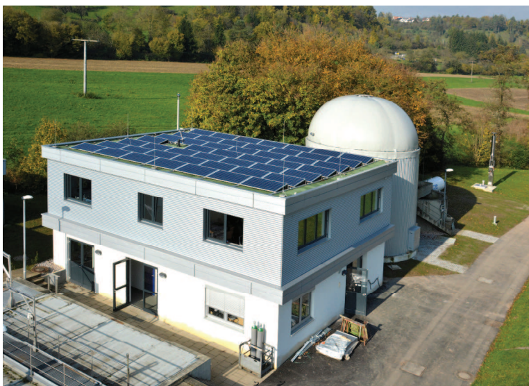
Betriebsgebäude der Kläranlage Waldenbuch mit Faulturm
