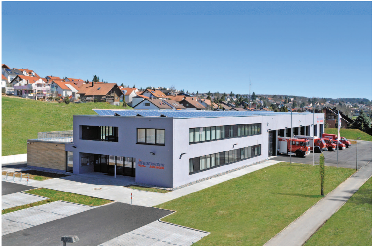
Photovoltaikanlage auf dem Feuerwehr-Gerätehaus
